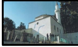
Fotoğraf 20. Rest. öncesi doğu cephe (BVBM)
