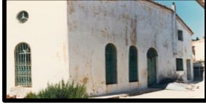
Fotoğraf 50. Rest. öncesi doğu cephe (BVBM)
