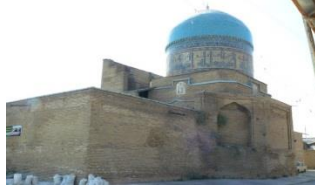
Resim 5: Gök Kubbe Camisi, kuzeybatı yönden batı cephesinin görünüşü
