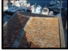
Fotoğraf 42. Çatı görünümü (N.Kıncal)
