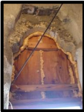
Fotoğraf 44. Minare iç duvarları (BVBM)
