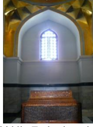
Resim 15: Şeyh Muslihiddin Türbesi, gürhane mekanı doğu duvarı
