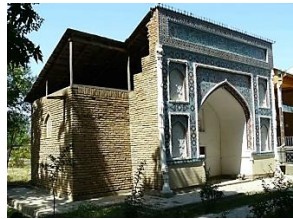
Resim 22: Adjina Han Türbesi, güneydoğu yönden bakış
