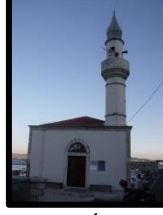
Fotoğraf 30. Rest. sonrası kuzey cephe (N. Kincal)
