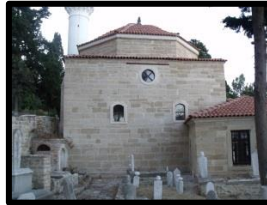
Fotoğraf 6. Güney cephe (N. Kınal)
