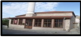
Fotoğraf 46. Rest. sonrası batı cephe (N. Kınal)
