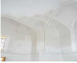
Resim 35: Abdulkadir Celoni Türbesi, kuzeybatı köşe duvarı
