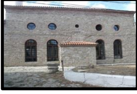
Fotoğraf 49. Rest. sonrası güney cephe (N. Kınal)
