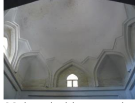
Resim 42: Mir Recep Dodko Medresesi, giriş eyvanının batısındaki mekanın üst örtüyü geçişleri
