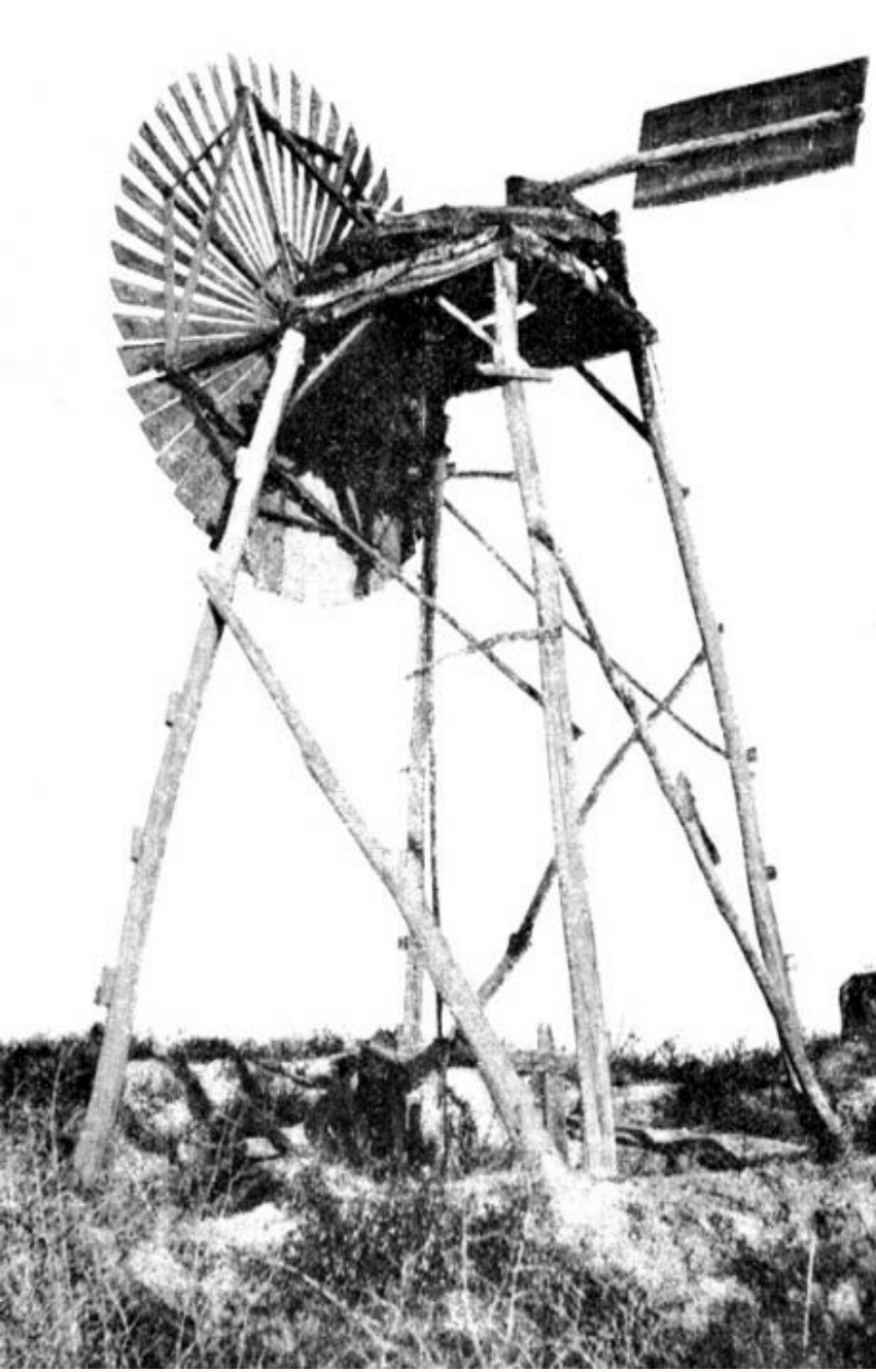
Resim 19: Rüzgar çıkıncı (rüzgarla çalışan sulama ünitesi), Sir bölgesi, 20. yüzyılın başları.
