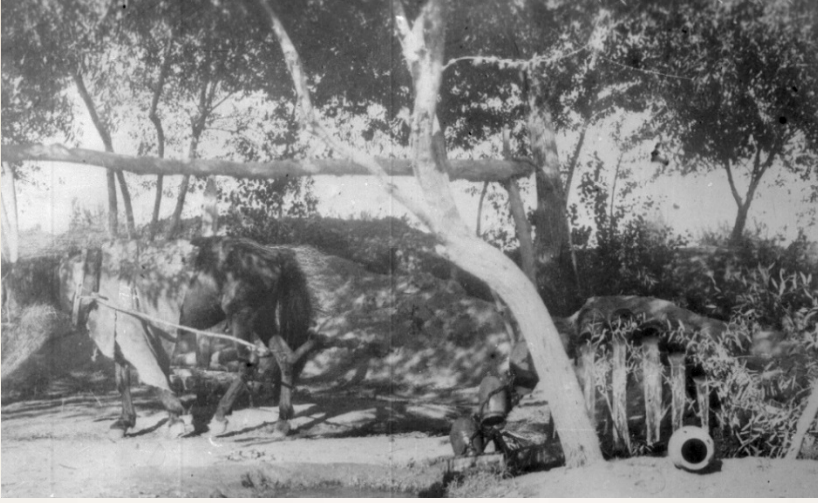
Resim 22: At çıkırığı (çıkırığı at yardımıyla harekete geçirme). 19. yüzyıl sonu. Kazakistan Cumhuriyeti Merkez Devlet Film ve Ses Kayıtları Arşivi'nden.
